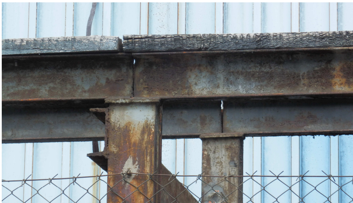
Fot. 8 widok połączenia słupków stalowych wiaty z płatwiami - brak uciąglenia płatwi nad podporami
