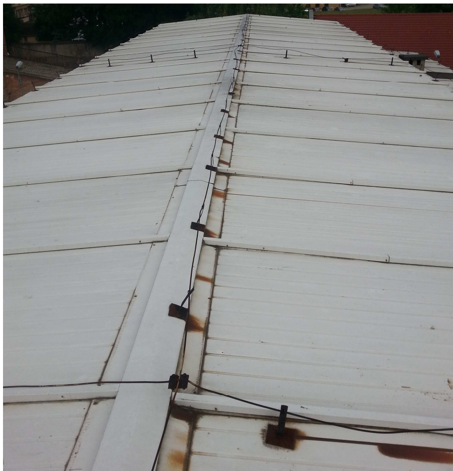
Fot. 3 Dach komory niskich temperatur - widoczny układ płyt warstwowych dachowych
