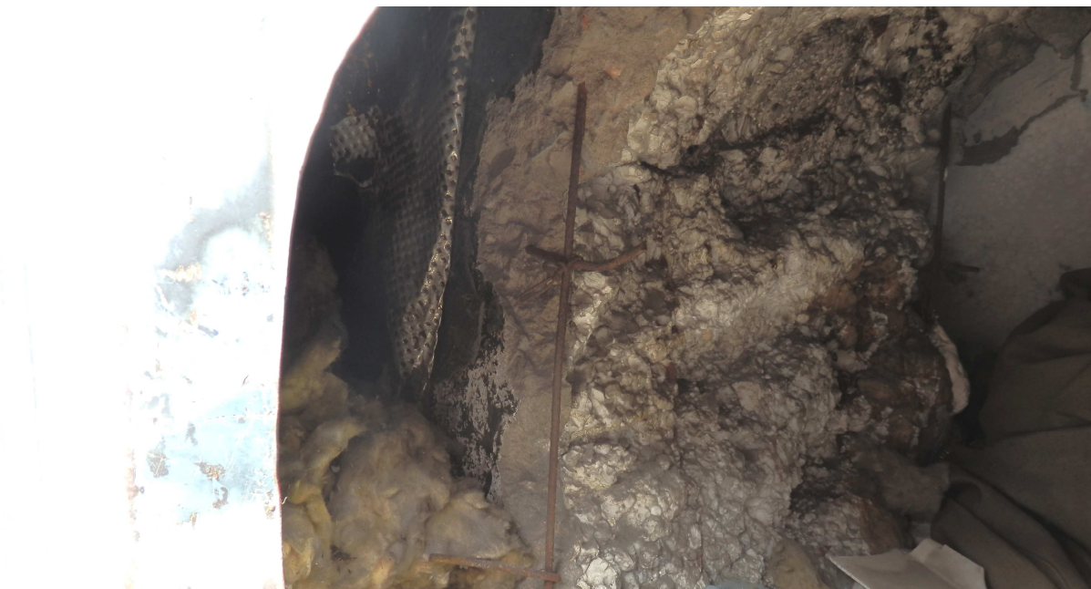
Fot. 5 Odkrywka przez ścianę komory niskich temperatur widoczne płyty warstwowe
