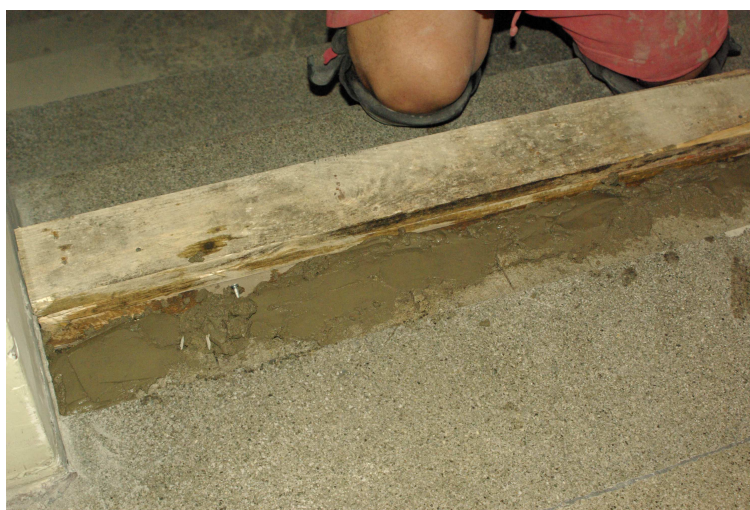
Szalowanie i zbrojenie uzupełnienia noska stopnia
