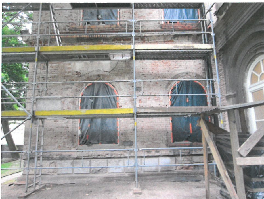
Fot.4. Druga ściana boczna ryzalitu na ścianie północnej budynku, widoczna dolna część. Usunięto w większości zmurszałe tynki i detal architektoniczny. Na ścianie widoczne niewielkie pozostałości pierwotnych tynków.
