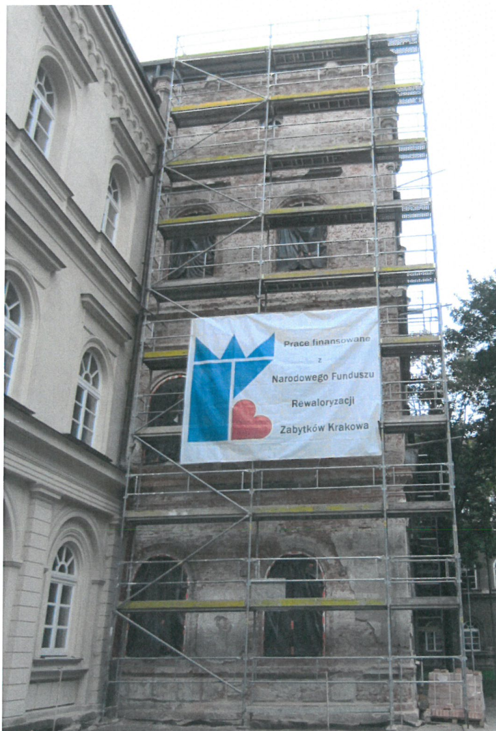
Fot.2. Ściana boczna ryzalitu na ścianie północnej budynku po wystawieniu rusztowań i usunięciu zmurszałych tynków i detali architektonicznych.
