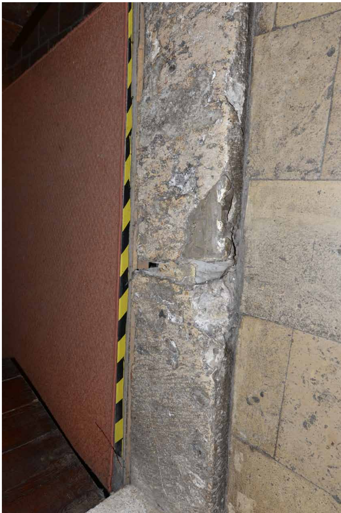
Fot. Nr 21 Kamienica przy ul. Kanoniczej 1. Politechnika im. T. Kościuszki w Krakowie. Widok portalu prowadzącego z korytarza do Sali Widowiskowej. Stan przed konserwacją, grudzień 2014 roku. Widoczny uszkodzony próg uzupełniany niewłaściwą masą.
