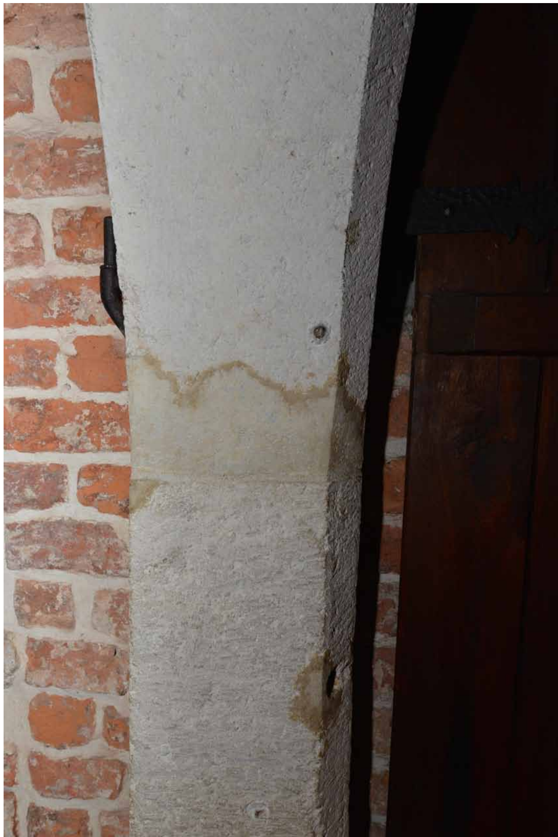
Fot. Nr 19 Kamienica przy ul. Kanoniczej 1. Politechnika im. T. Kościuszki w Krakowie. Widok portalu prowadzącego z korytarza do Galerii. Stan przed konserwacją, grudzień 2014 roku. Widoczne przebarwienia uzupełnień wykonanych w roku 1989 w skutek użycia jako spoiwa kitów Epidianu 5.
