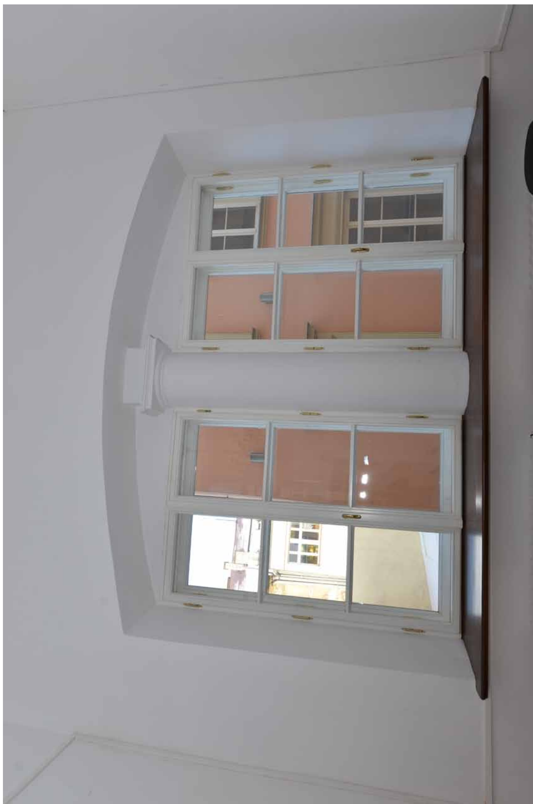
Fot. Nr 56 Kamienica przy ul. Kanoniczej 1. Politechnika im. T. Kościuszki w Krakowie. Widok biforiowego okna w pomieszczeniu nr 102 na I piętrze. Niekonsekwentnie zamalowana piaskowcowa kolumna dekorująca okno — powinien być ekspozowany kamień. Stan przed konserwacją, grudzień 2014 roku.
