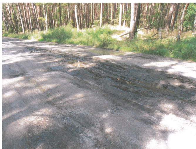
Rys. 4. km 0+600 – 0+640. Brak spadków poprzecznych powodujący zaleganie wód opadowych- konieczność wykonania dodatkowo warstwy odsączającej z piasku.
