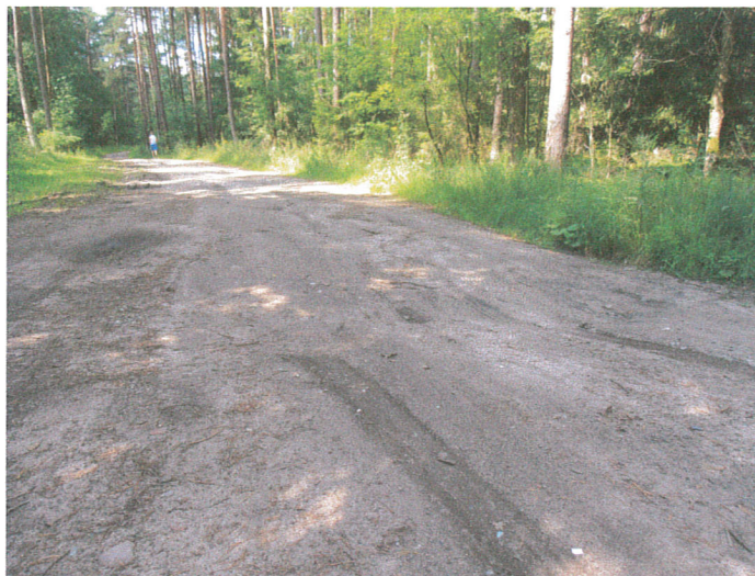
Rys. 3. km 0+300 - 0+330. Brak spadków poprzecznych powodujący zaleganie wód opadowych
