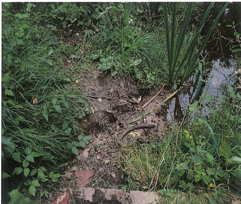
Fot. 7. Miejsce przelewania się nadmiaru wody przez groble – lewa strona.
