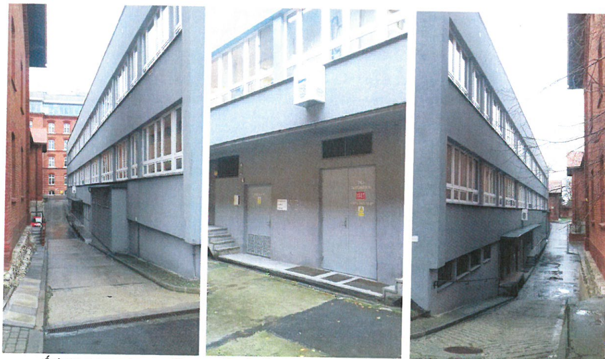
Ściana zewnętrzna północna budynku W-7 docelowo do dostosowania do wymagania ściany oddzielenia przeciwpożarowego, z drzwiami i roletami/kurtynami przeciwpożarowymi przedmiot odstępstwa. Elewacja od strony budynku byłego aresztu tj. W-8.
