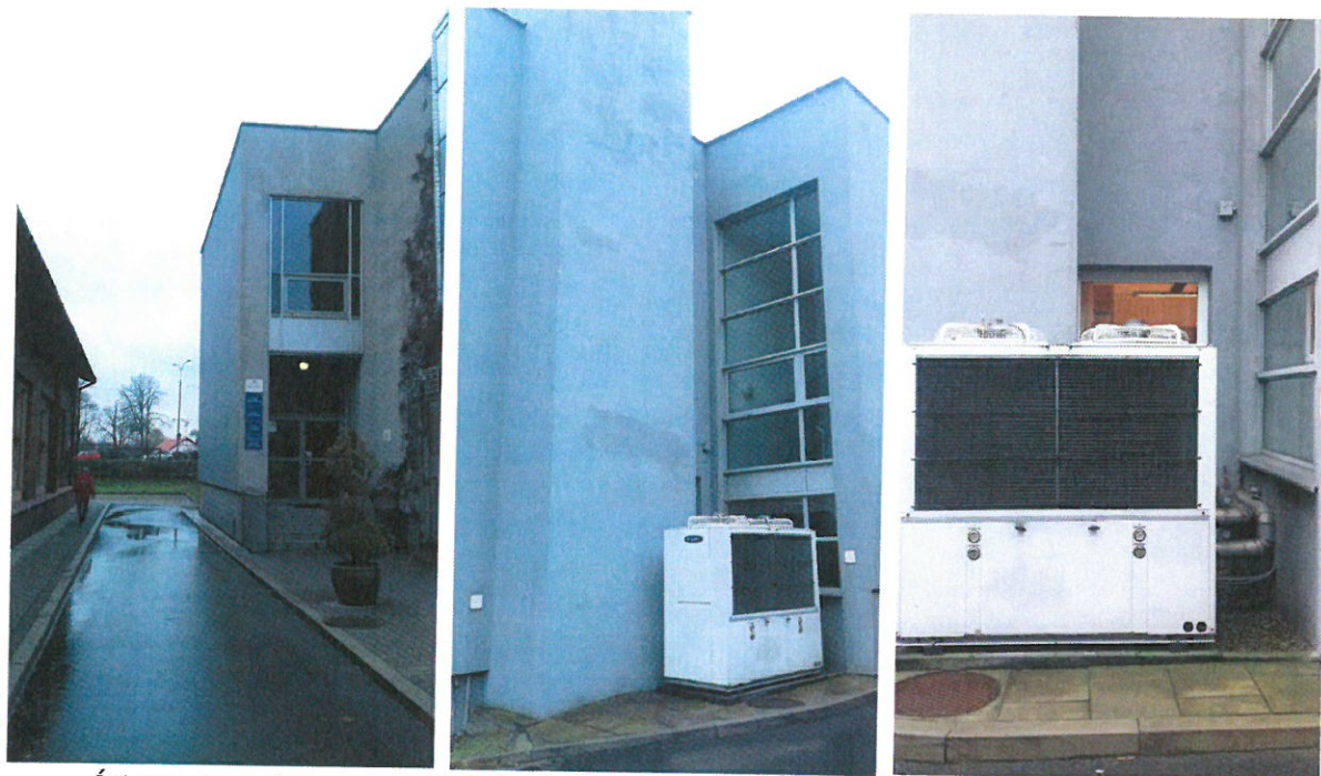
Ściana zewnętrzna zachodnia budynku W-7 docelowo do dostosowania do wymagania ściany oddzielenia przeciwpożarowego.
