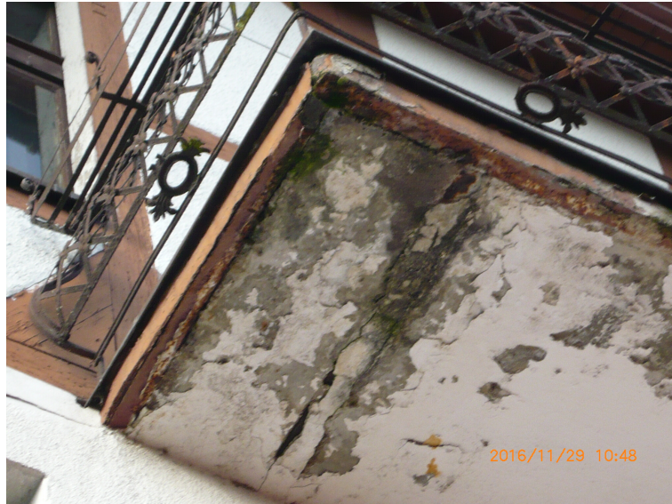
Zdjęcie nr 4: Stalowa konstrukcja balkonów uszkodzona przez korozję
