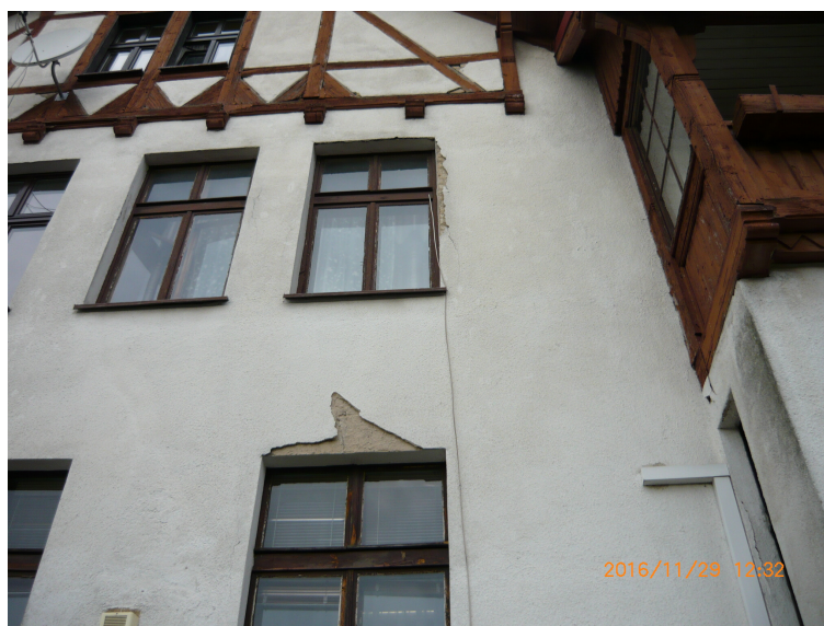
Zdjęcie nr 12: Uszkodzenia tynków zewnętrznych
