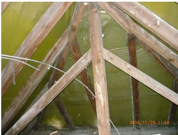
Zdjęcie nr 7: Wiażar wieszarowo – rozporowy w części konstrukcji dachu
