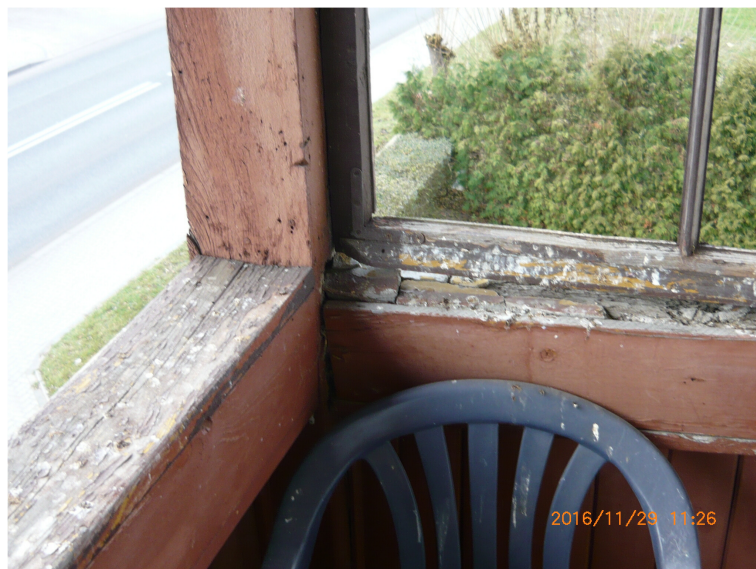
Zdjęcie nr 5: Drewniane elementy nośne loggii od strony elewacji południowej
