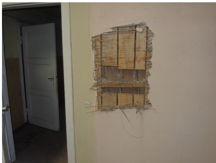
Zdjęcie nr 6: Ściany działowe IV kondygnacji w lekkiej konstrukcji drewnianej
