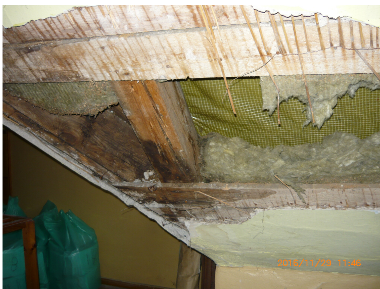
Zdjęcie nr 9: Uszkodzenia przez korozję biologiczną elementów drewnianych więźby dachowej na IV kondygnacji
