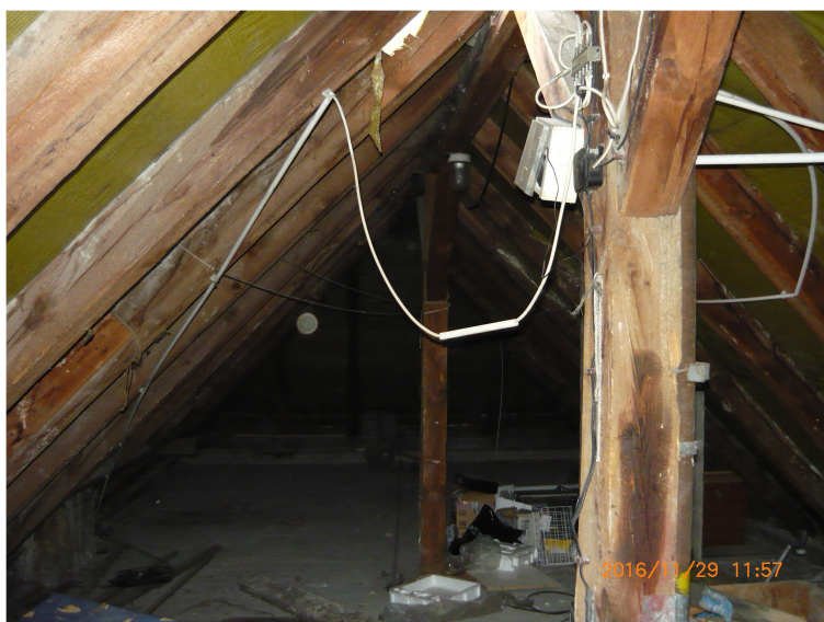
Zdjęcie nr 8: Układ płatwiowo – kleszczowy konstrukcji więźby dachowej
