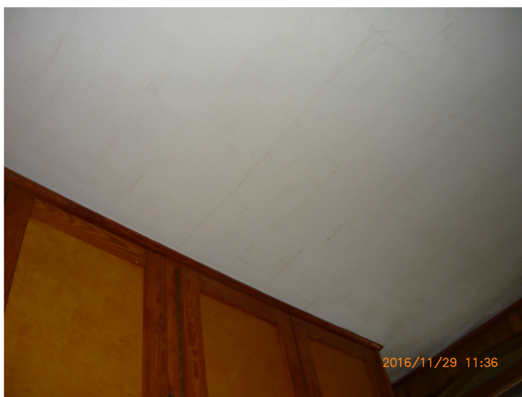
Zdjęcie nr 3: Widoczne rysy wzdłuż drewnianych belek stropowych
