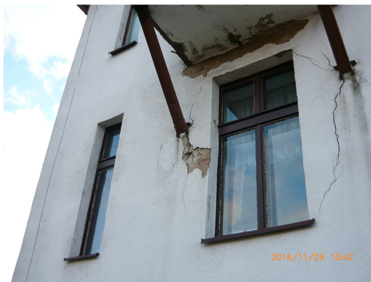
Zdjęcie nr 1: Uszkodzenie muru w miejscach oparcia balkonów na ścianie
