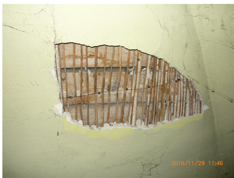
Zdjęcie nr 11: Zły stan techniczny tynków wapiennych na IV kondygnacji
