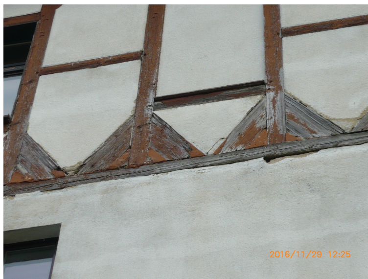
Zdjęcie nr 10: Uszkodzone elementy drewniane więźby dachowej detalu architektonicznego
