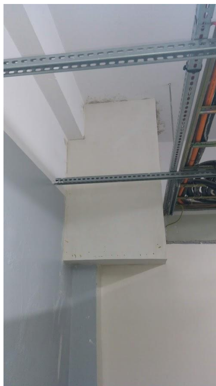
Rysunek 2,3 Pomieszczenie serwerowni, konstrukcja wsporcza stropu DZ-3
