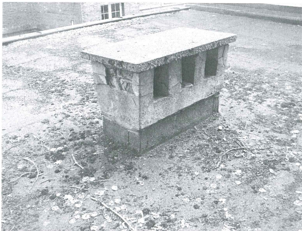
Zdj.3- Połąć dachu z murowanym kominem wentylacyjnym.
