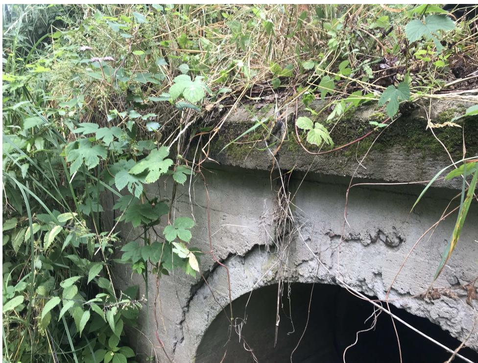
fot. nr 2. Zbliżenie miejsca uszkodzenia. Część ścianki czołowej odchyliła się od pionu i odspoiła od przewodu przepustu.
