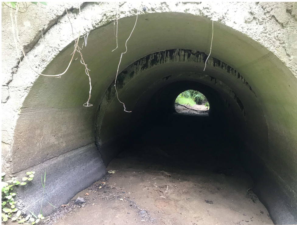
fot. nr 3. Przewód przepustu od strony poszuru. Rozszczelnienie i przemieszczenie poszczególnych rur przewodu ( błędy wykonawcze ). Przepust wykonany w przeciwnospadku, efekt zalegający namul.
