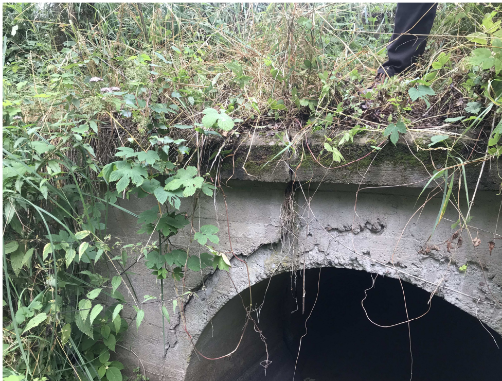
fot. nr 1. Widok ogólny ściankę czołową od strony poszuru. Widoczne uszkodzenie ścianki czołowej, pęknięcie zagrażające trwałości obiektu.
