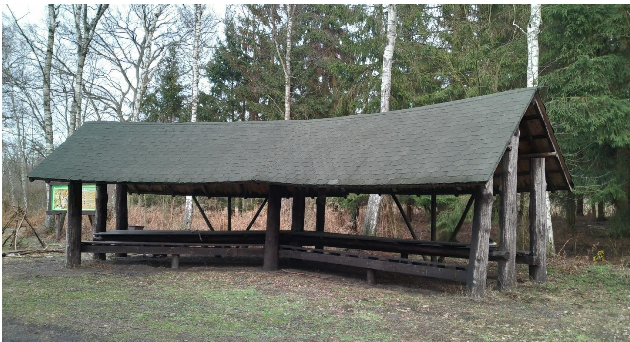
Fot. nr 1. Wiata (Lokalizacja „A”) – widok od frontu, długość okapu wewn. 9,4m, zewn. 12,2m
