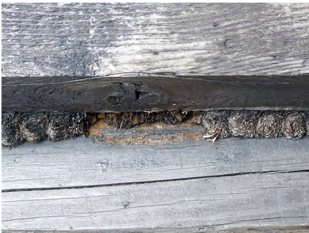
36. Zakopane, ul.Nowotarska 59, willa "Stara Polana", elewacja zachodnia. Widoczne braki w mszeniu.
