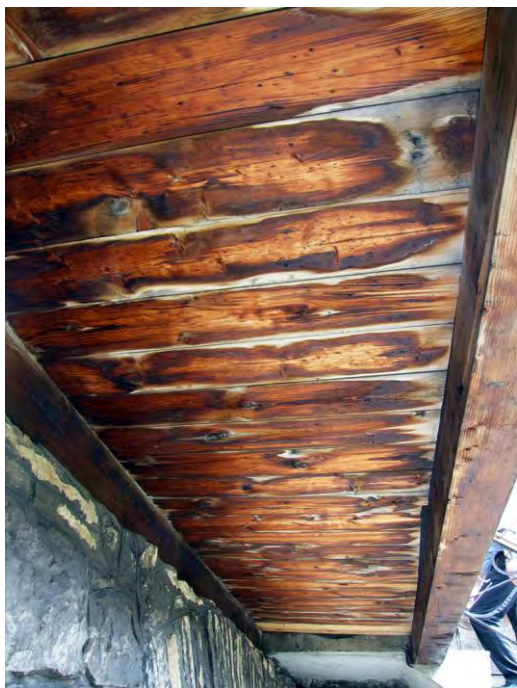
8. Zakopane, ul.Nowotarska 59, willa "Stara Polana", elewacja wschodnia, tzw.chodnik południowy. Podłoga chodnika pokryta licznymi zaciekami - widok od spodu.
