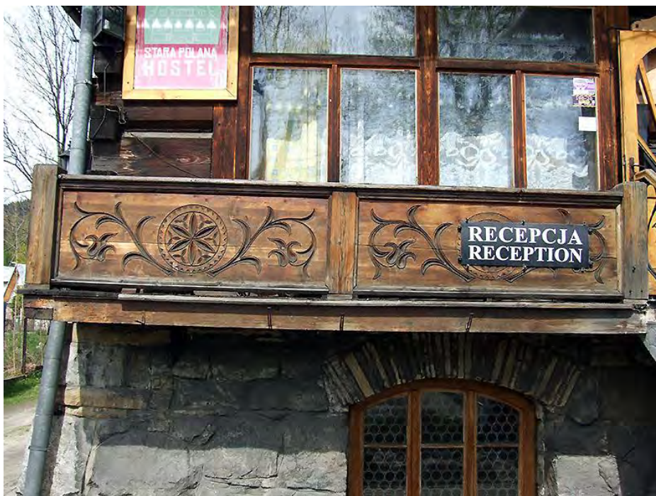
6. Zakopane, ul.Nowotarska 59, willa "Stara Polana", elewacja wschodnia, tzw.chodnik południowy. Ubytki obróbek blacharskich.
