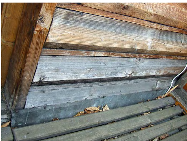
52. Zakopane, ul.Nowotarska 59, willa "Stara Polana", część dobudowana, elewacja północna, na poziomie balkonu. Widoczne osłonięcie łączenia podłogi balkonu z ścianą za pomocą kawałka blachy.
