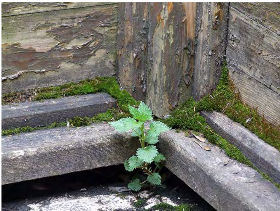
42. Zakopane, ul.Nowotarska 59, willa "Stara Polana", balustrada tarasu przy elewacji północnej, widok od strony wewnętrznej. Widoczne skupiska mchów porastające zawilgocone, pociemniałe i pokryte resztkami lakieru drewno.
