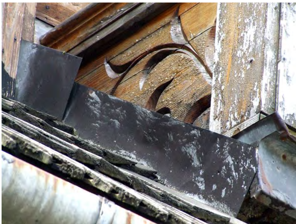
51. Zakopane, ul.Nowotarska 59, willa "Stara Polana", elewacja zachodnia, tzw.wygląd z balkonem, fragment boczny balustrady. Widoczne niestaranne obróbki blacharskie, niespełniające swojej funkcji.
