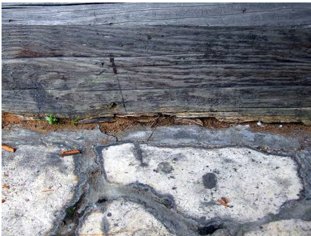
35. Zakopane, ul.Nowotarska 59, willa "Stara Polana", elewacja zachodnia, rozpad drewna na styku z posadzką tarasu.
