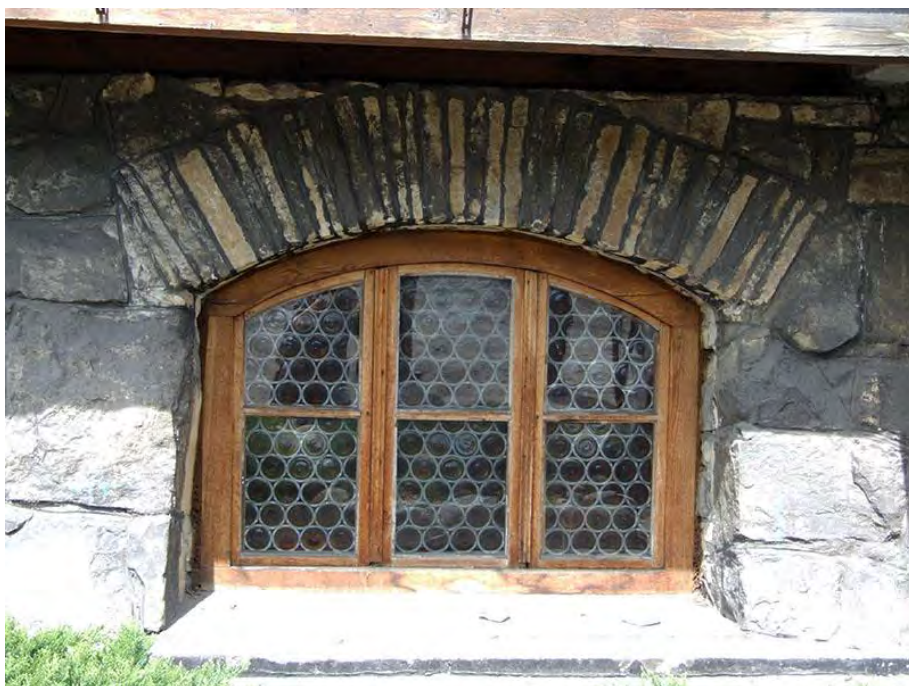
9. Zakopane, ul.Nowotarska 59, willa "Stara Polana", elewacja wschodnia, okno w przyziemiu. Widoczne zabrudzenie ciosów kamiennych.
