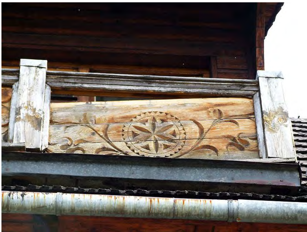
59. Zakopane, ul.Nowotarska 59, willa "Stara Polana", elewacja południowa. Widoczny zły stan zachowania balustrady balkonu - przemieszczenie desek z ornamentem.
