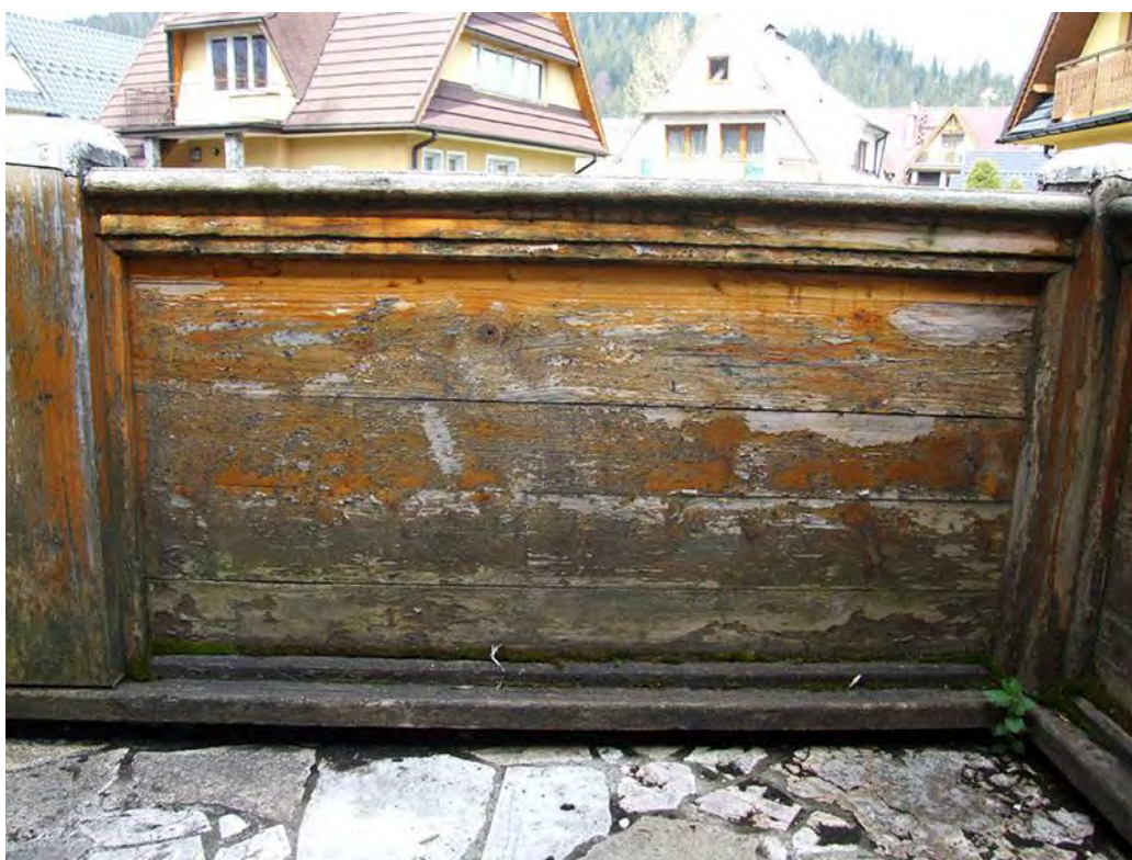
30. Zakopane, ul.Nowotarska 59, willa "Stara Polana", balustrada tarasu od strony wewnętrznej. Widoczne pociemniałe, zdegradowane drewno w dolnej części oraz łuszczące się warstwy lakieru bezbarwnego.
