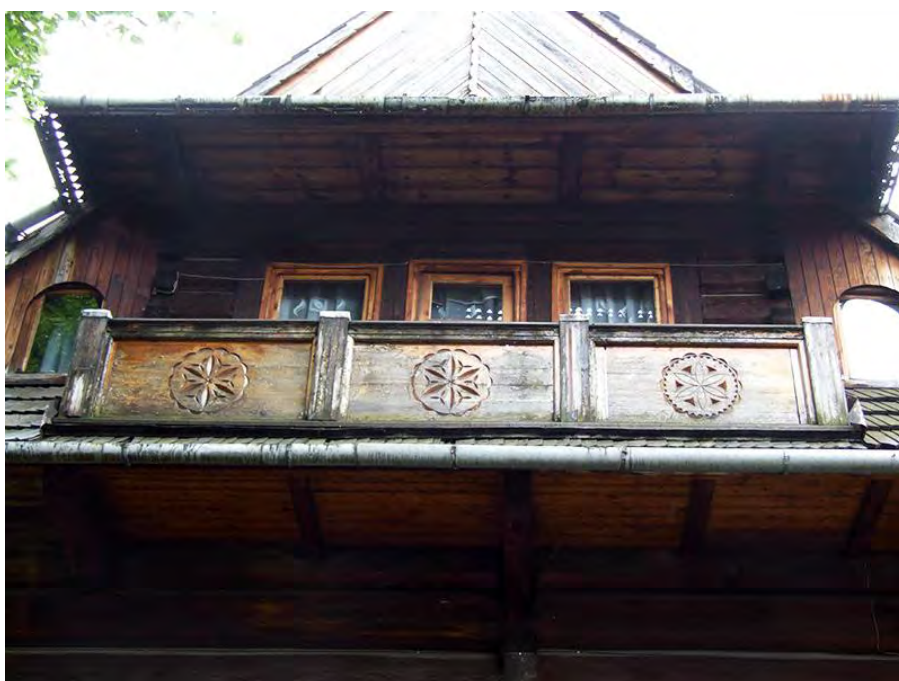
20. Zakopane, ul.Nowotarska 59, willa "Stara Polana", elewacja północna. Balkon w szczycie budynku. Widoczna korozja biologiczna w obrębie balustrady i gontów położonych poniżej.
