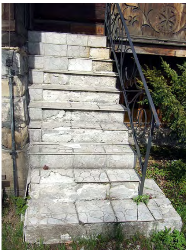
12. Zakopane, ul.Nowotarska 59, willa "Stara Polana" elewacja wschodnia, wtórne schody północne. Zniszczona ceramiczna okładzina schodów.
