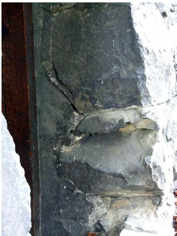
23. Zakopane, ul.Nowotarska 59, willa "Stara Polana", elewacja północna. Ubytki i zabrudzenie wątków w strefie podmurówki.
