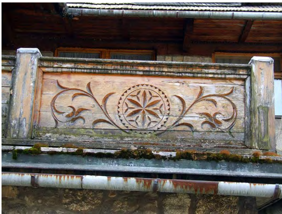
27. Zakopane, ul.Nowotarska 59, willa "Stara Polana", elewacja północna. Widoczny zły stan zachowania balustrady tarasu. Drewno zaatakowane przez mikroorganizmy - szczególnie w obrębie najniższej położonej deski.
