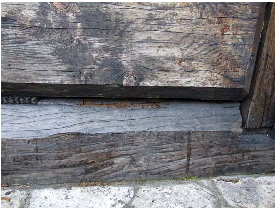
37. Zakopane, ul.Nowotarska 59, willa "Stara Polana", elewacja zachodnia. Widoczne braki w mszeniu.
