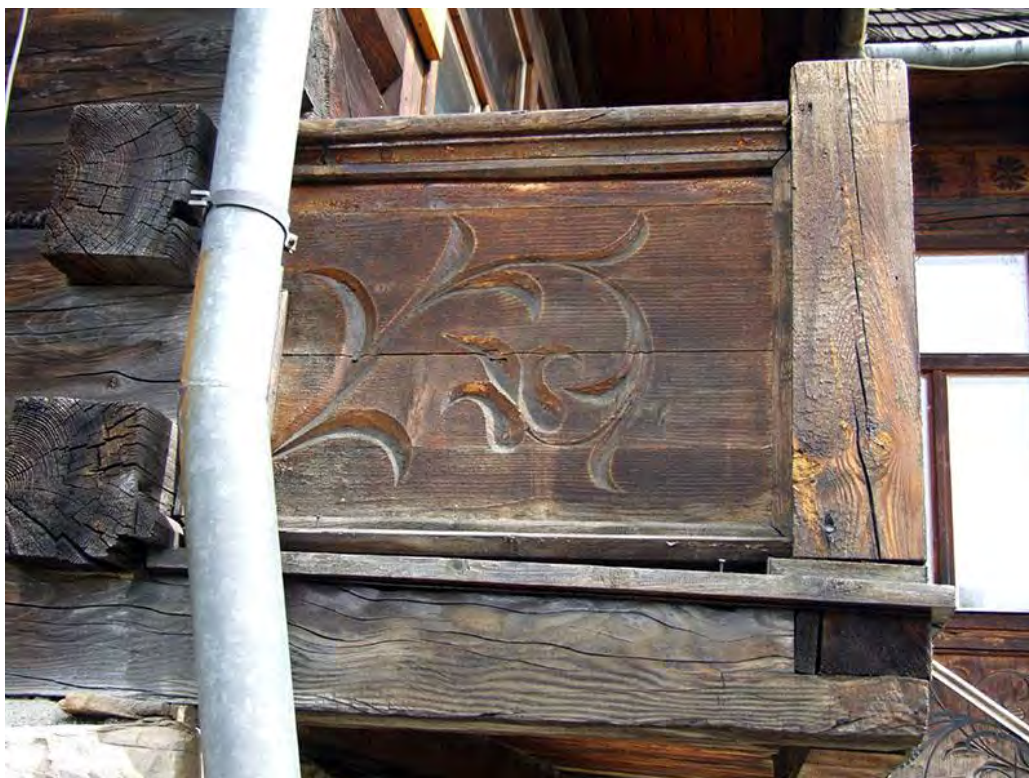
71. Zakopane, ul.Nowotarska 59, willa "Stara Polana", narożnik elewacji południowej i wschodniej. Widoczna wadliwa rura spustowa oraz rozluźnienie się i rozsuniecie elementów balkonu.
