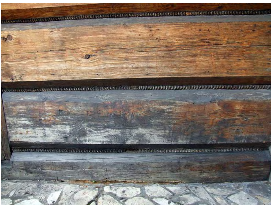
34. Zakopane, ul.Nowotarska 59, willa "Stara Polana", elewacja zachodnia, zaplamienia i przebarwienia drewna w wyniku zawilgocenia, ubytki mszenia.
