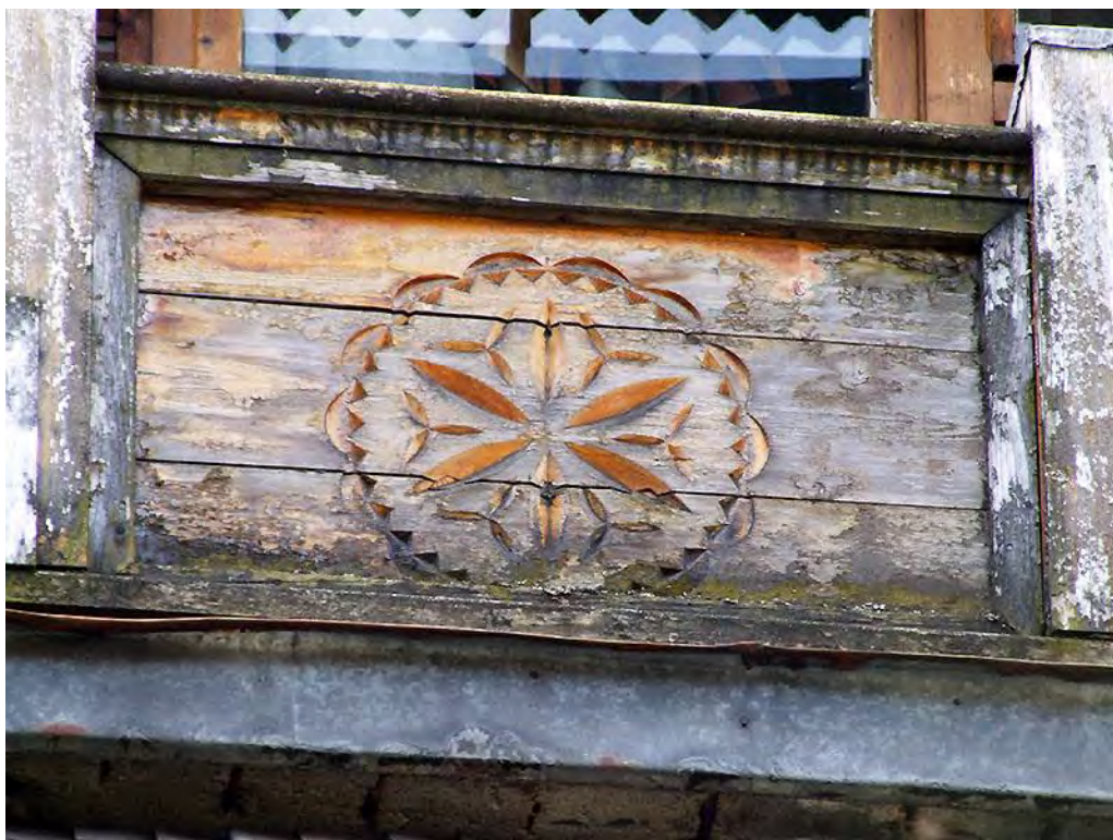
49. Zakopane, ul.Nowotarska 59, willa "Stara Polana", elewacja zachodnia, tzw.wygląd z balkonem. Widoczne rozległe zniszczenia elementów drewnianych balustrady balkonu.
