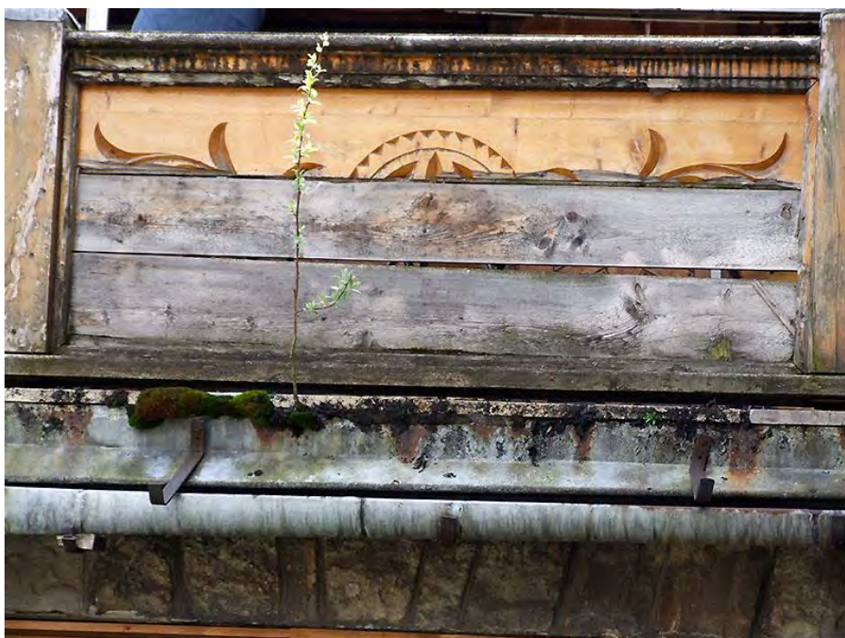
31. Zakopane, ul.Nowotarska 59, willa "Stara Polana", elewacja zachodnia. Widoczny zły stan zachowania balustrady tarasu - zniszczone deski z wycinanymi ornamentami zastąpiono prostymi deskami.
