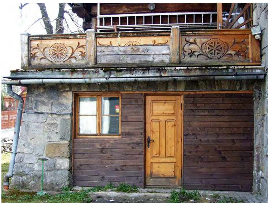
28. Zakopane, ul.Nowotarska 59, willa "Stara Polana", elewacja zachodnia. Widoczny zły stan zachowania balustrady tarasu.
