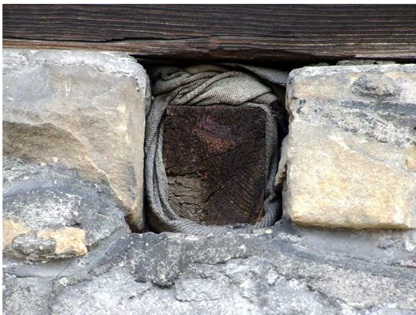
66. Zakopane, ul.Nowotarska 59, willa "Stara Polana", elewacja południowa. Wadliwe technologicznie wypełnienia łączń kamienia z drewnem.
