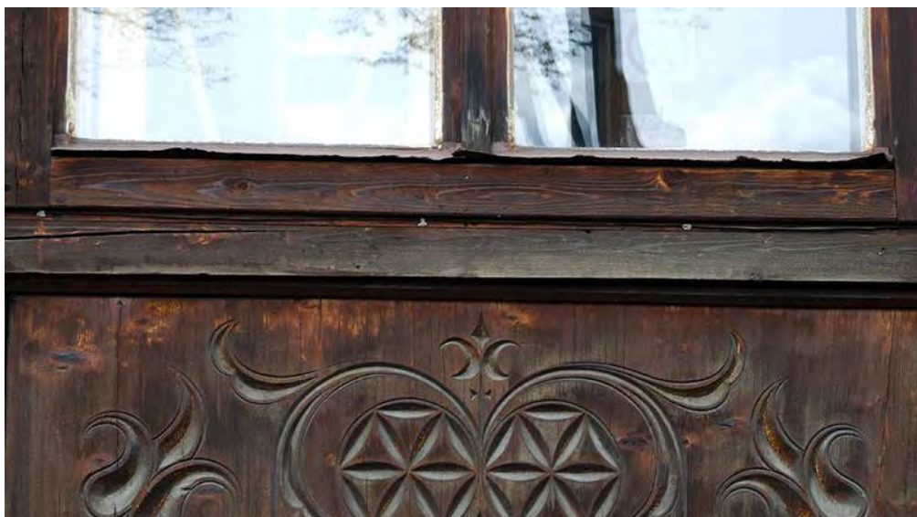
11. Zakopane, ul.Nowotarska 59, willa "Stara Polana" elewacja wschodnia, weranda. Całkowicie zdegradowane obróbki blacharskie skrzydeł okiennych.
