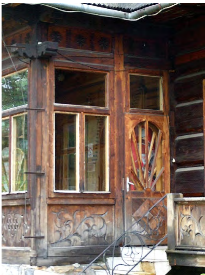
16. Zakopane, ul.Nowotarska 59, willa "Stara Polana" elewacja wschodnia, północne wejście na werandę. Widoczne rozległe strefy zawilgoceń w części położonej bezpośrednio nad podmurówką.
