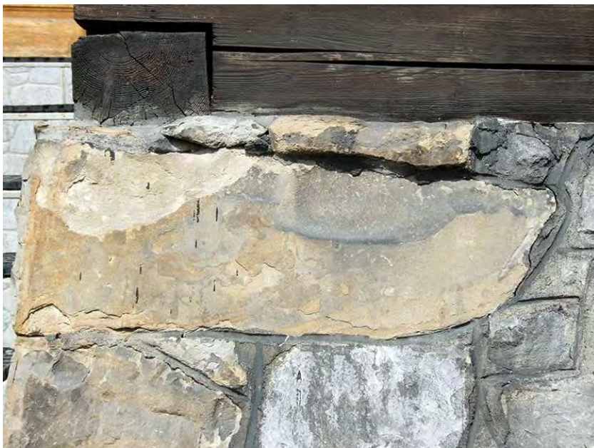
17. Zakopane, ul.Nowotarska 59, willa "Stara Polana" elewacja wschodnia. Rozwarstwiony i złuszczony cios w cokole.
