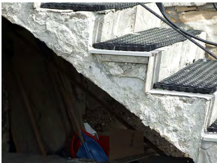
15. Zakopane, ul.Nowotarska 59, willa "Stara Polana" elewacja wschodnia, schody południowe. Ceramiczna okładzina schodów odpadła, beton złuszczone i rozwarstwiony.
