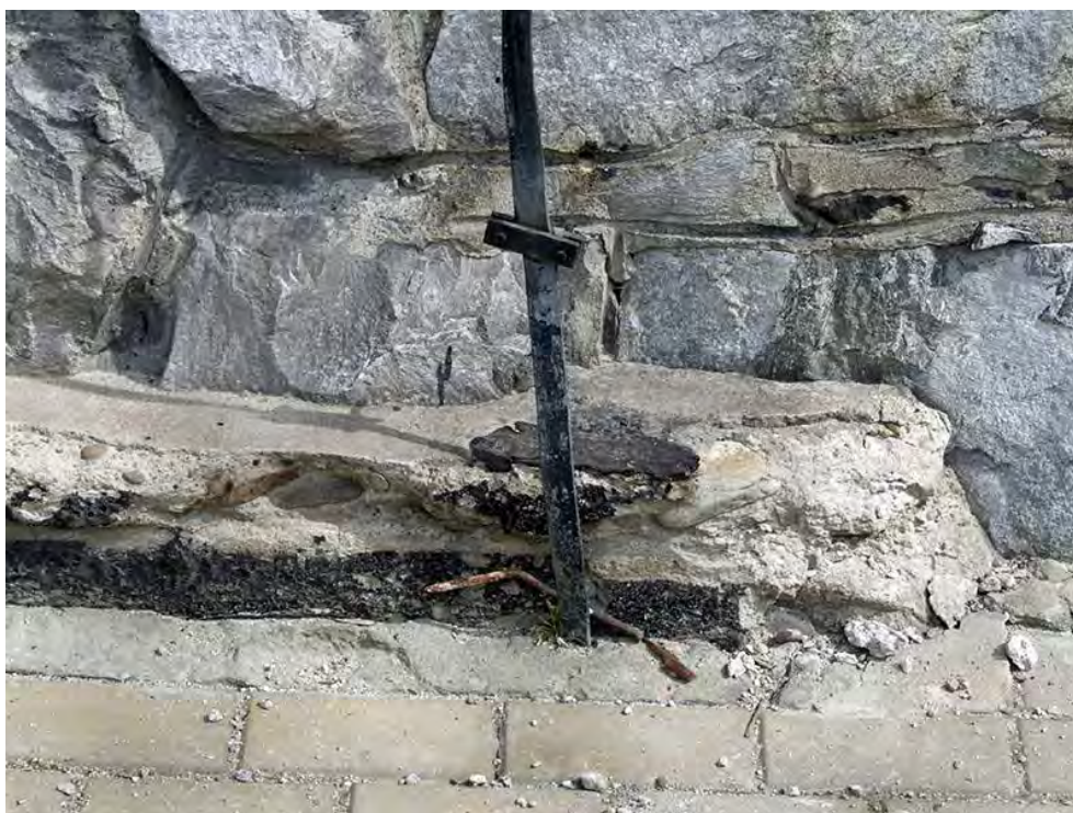
68. Zakopane, ul.Nowotarska 59, willa "Stara Polana", elewacja południowa. Pozostałości opaski betonowej (?).
