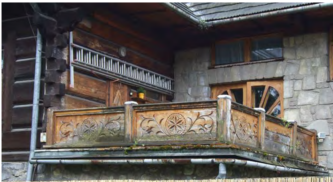
25. Zakopane, ul.Nowotarska 59, willa "Stara Polana", taras przy elewacji północnej. Widoczne zwłaszcza w dolnych rejonach balustrad strefy zawilgocone i uszkodzone wskutek korozji biologicznej.
