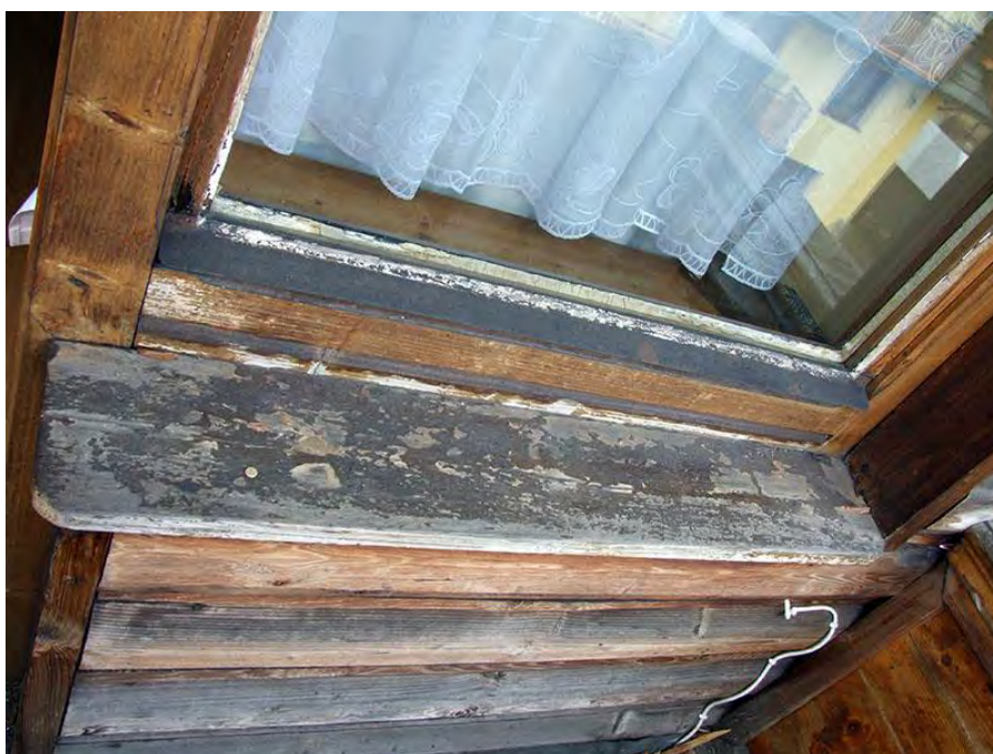
60. Zakopane, ul.Nowotarska 59, willa "Stara Polana", elewacja południowa, poziom balkonu. Widoczne wtórne powłoki malarskie na parapecie okna.
