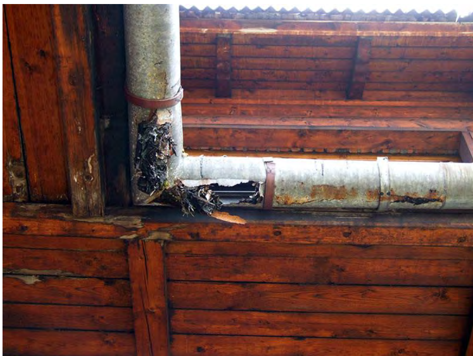
41. Zakopane, ul.Nowotarska 59, willa "Stara Polana", narożnik dachu nad elewacją północną i zachodnią. Rozległe uszkodzenia rynien w rejonie tarasu.
