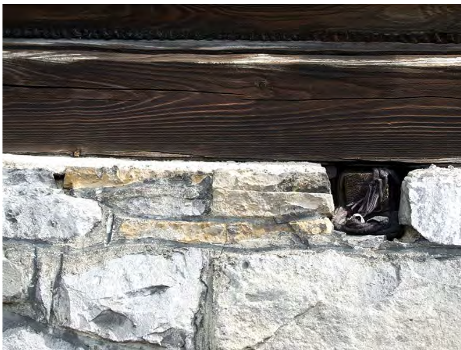
67. Zakopane, ul.Nowotarska 59, willa "Stara Polana", elewacja południowa. Wadliwe technologicznie wypełnienia łączy kamienia z drewnem.
