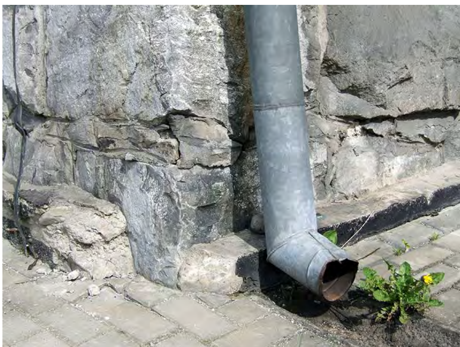
70. Zakopane, ul.Nowotarska 59, willa "Stara Polana", narożnik elewacji południowej i wschodniej. Wykruszenia spoinowania i zapraw w rejonie rury spustowej.
