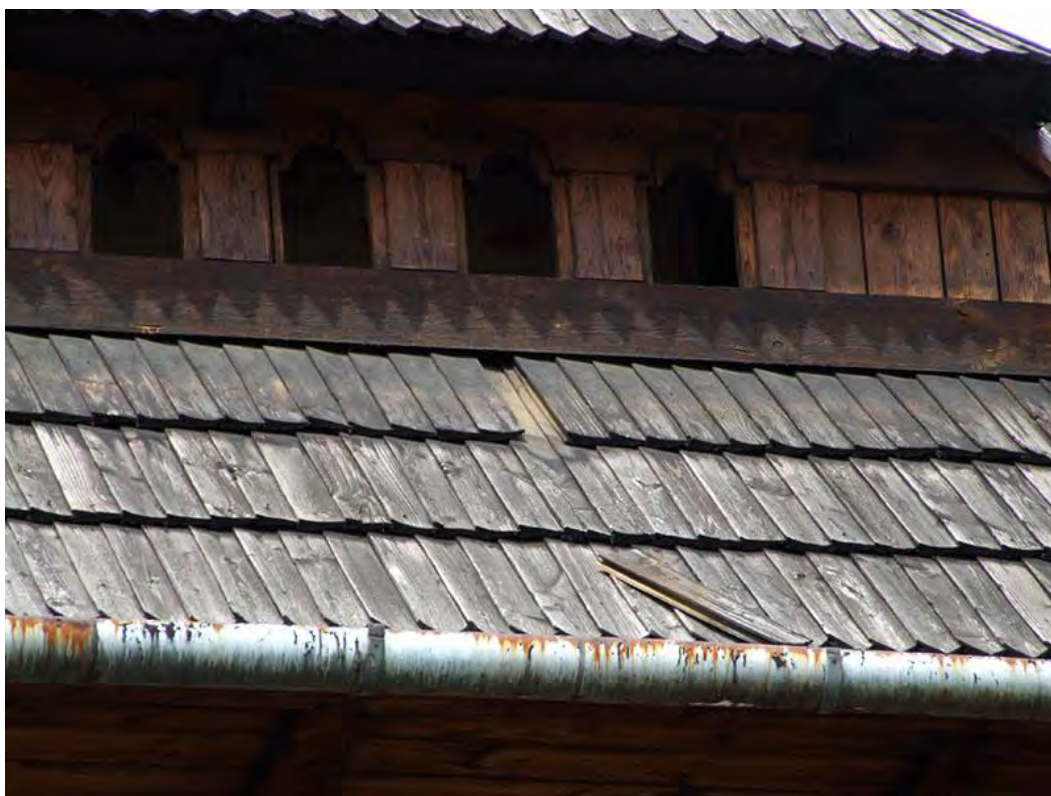
3. Zakopane, ul.Nowotarska 59, willa "Stara Polana", elewacja wschodnia, ubytki gontu.
