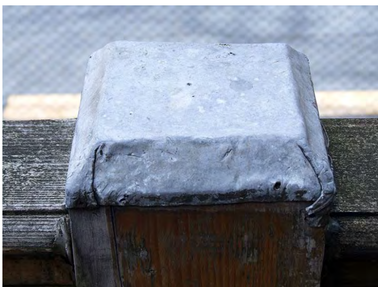
64. Zakopane, ul.Nowotarska 59, willa "Stara Polana". Wtórne osłonięcie blachą górnej powierzchni słupka balustrady.
