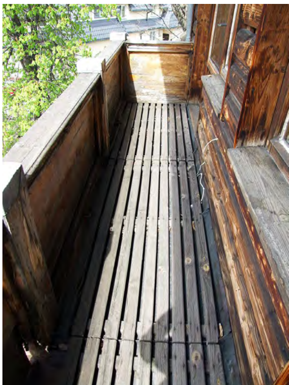
61. Zakopane, ul.Nowotarska 59, willa "Stara Polana", elewacja południowa, kratownica z listew na podłodze balkonu.
