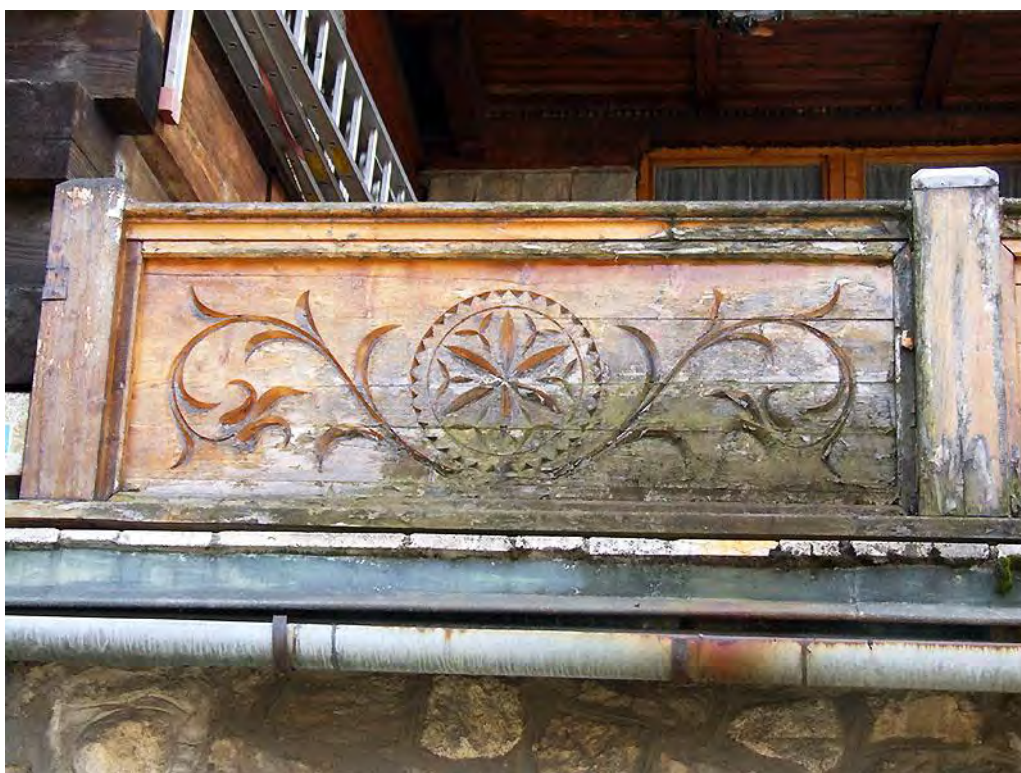
26. Zakopane, ul.Nowotarska 59, willa "Stara Polana", elewacja północna. Widoczny zły stan zachowania balustrady tarasu. Drewno zaatakowane przez mikroorganizmy, obróbki blacharskie zdegradowane..
