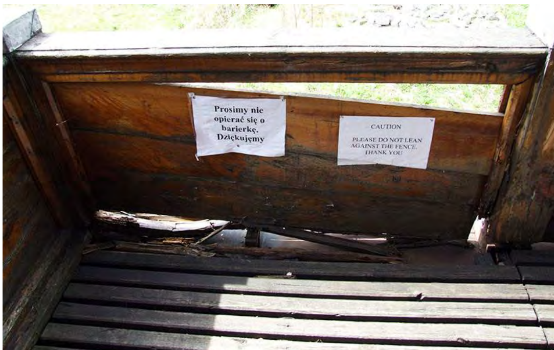
63. Zakopane, ul.Nowotarska 59, willa "Stara Polana" elewacja południowa, strona północna balustrady balkonu. Całkowite wygnicie drewna w dolnej części ramy spowodowało wypadnięcie z niej desek.
