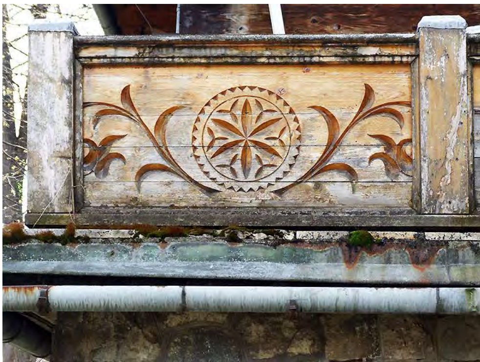
29. Zakopane, ul.Nowotarska 59, willa "Stara Polana", elewacja zachodnia. Widoczny zły stan zachowania balustrady tarasu.
