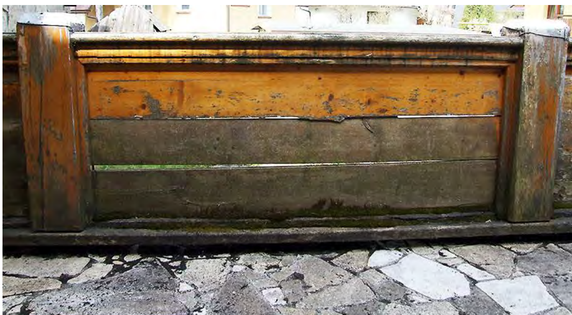
32. Zakopane, ul.Nowotarska 59, willa "Stara Polana", balustrada zachodnia tarasu, widok od strony wschodniej. Widoczne uszkodzenia wskutek długotrwałego zawilgocenia. Dwie dolne deski wymienione.
