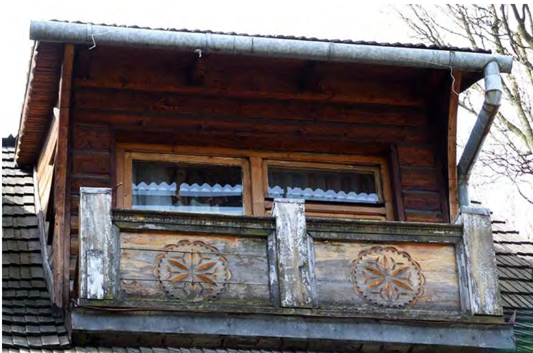
48. Zakopane, ul.Nowotarska 59, willa "Stara Polana", elewacja zachodnia, tzw.wygląd z balkonem. Widoczne przebarwienia i zaplamienia na elementach drewnianych balustrady balkonu.
