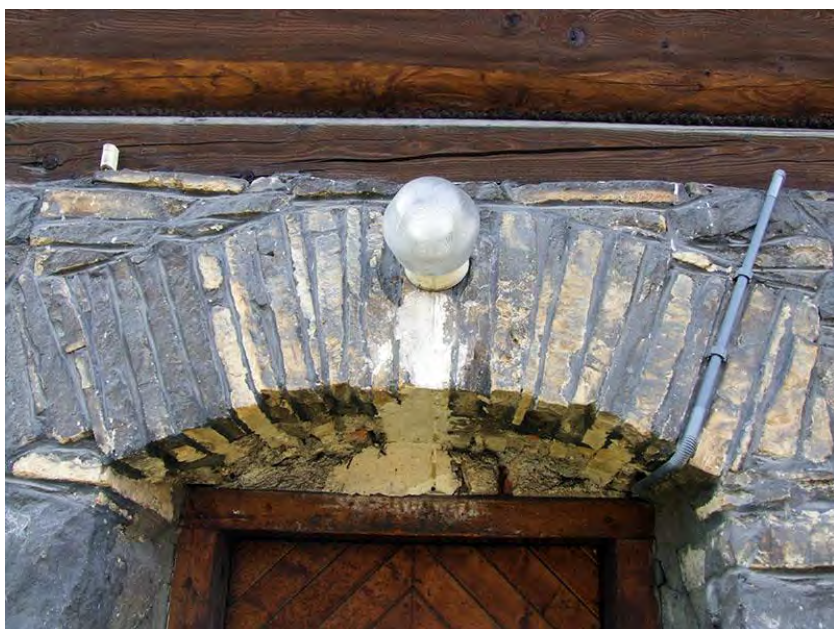
24. Zakopane, ul.Nowotarska 59, willa "Stara Polana", elewacja północna. Przekucia pod instalację elektryczną zatarte gipsem.
