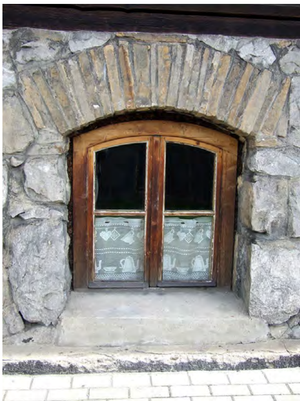
65. Zakopane, ul.Nowotarska 59, willa "Stara Polana", elewacja południowa. Zabrudzenie wątków kamiennych, lokalne wykruszenie spoin.
