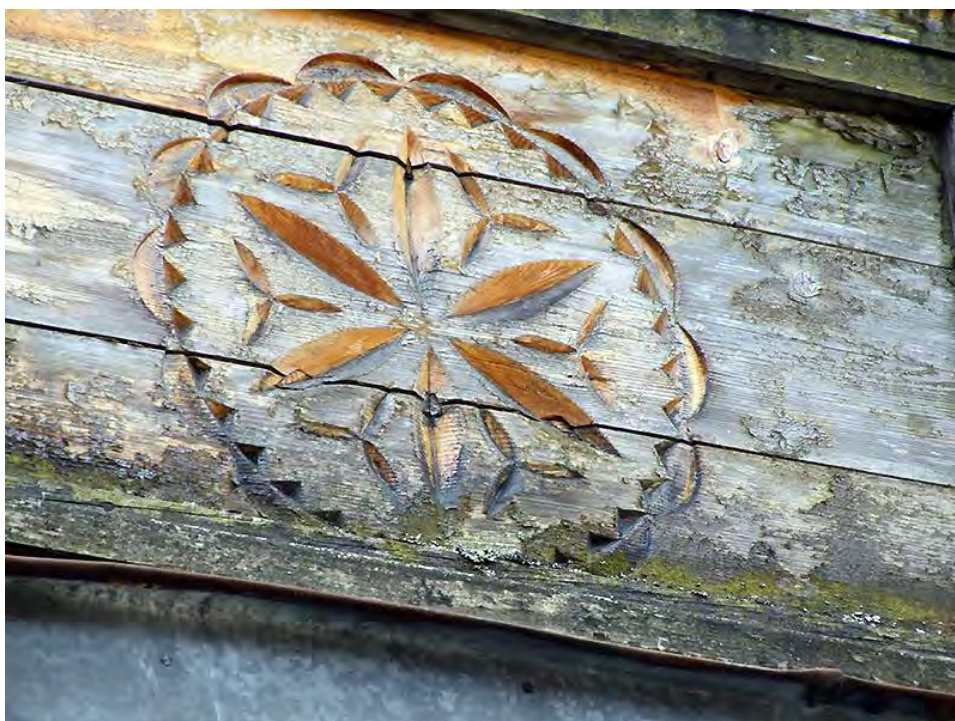
50. Zakopane, ul.Nowotarska 59, willa "Stara Polana", elewacja zachodnia, tzw.wygląd z balkonem, fragment balustrady. Widoczna korozja biologiczna drewna i resztki lakierów bezbarwnych.
