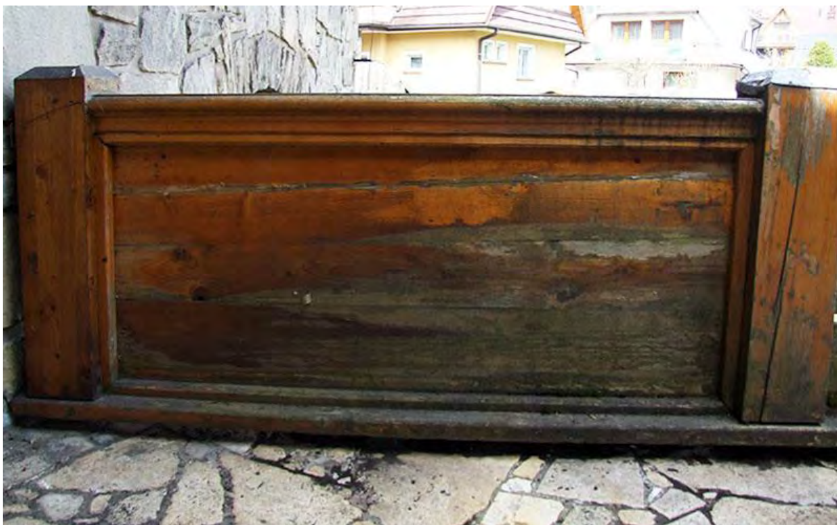
33. Zakopane, ul.Nowotarska 59, willa "Stara Polana", balustrada zachodnia tarasu, widok od strony wschodniej. Widoczne wtórne łuszczące się powłoki lakierów oraz uszkodzenia wskutek długotrwałego zawilgocenia.
