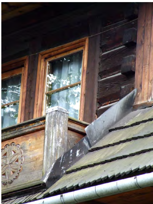
21. Zakopane, ul.Nowotarska 59, willa "Stara Polana", elewacja północna, balkon w szczycie, Widoczne niestaranne obróbki blacharskie na łączeniu balkonu z dachem oraz na słupku, które nie spełniają swojej funkcji.
