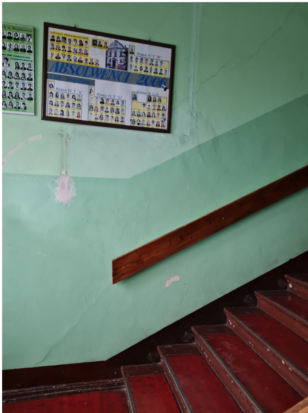
Fotografia 7. Drewniane pochwyty wzdłuż ściany klatki schodowej.
