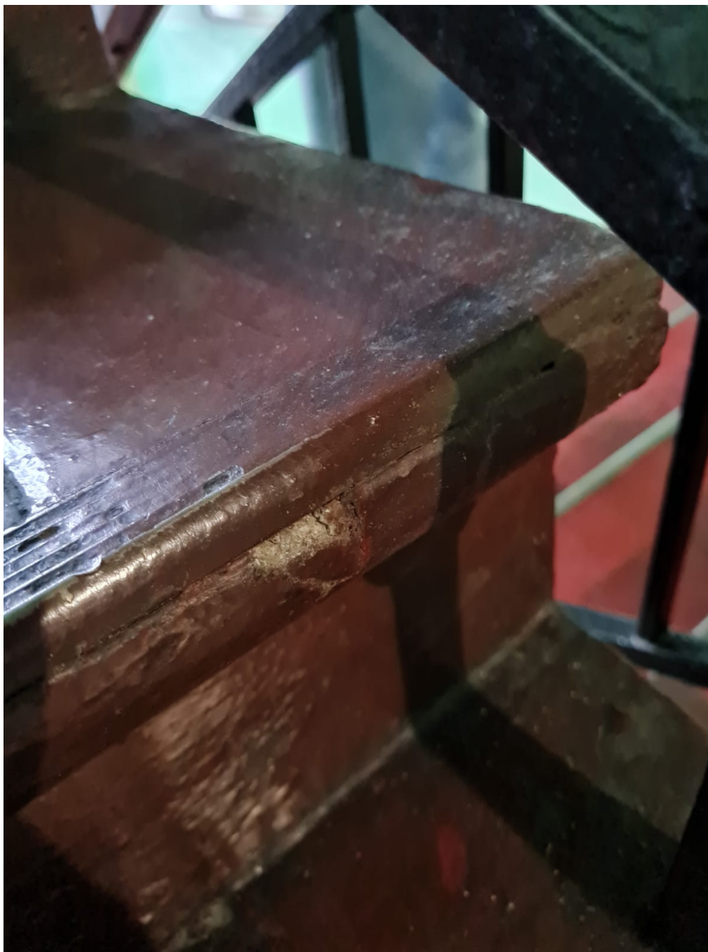
Fotografia 6. Detal pęknięcia warstwy wykończeniowej schodów.
