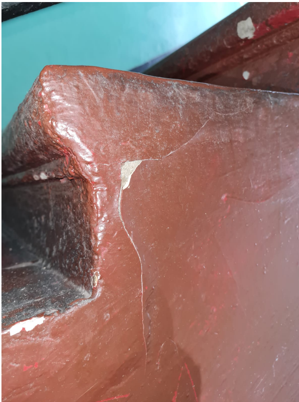
Fotografia 5. Detal pęknięcia warstwy wykończeniowej schodów.
