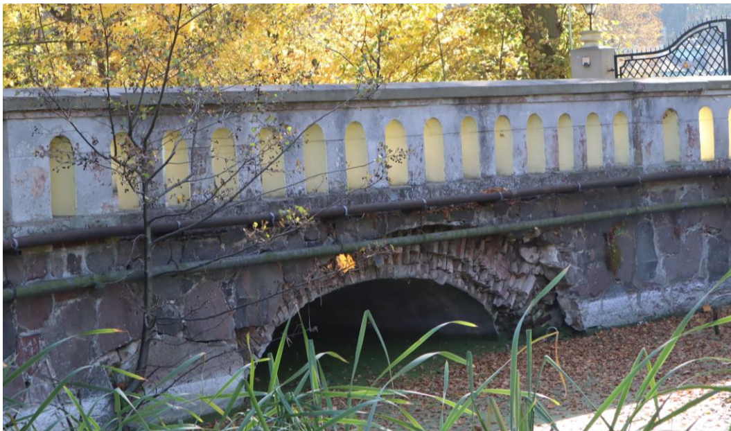
Fot. 3. Widok obiektu od strony północno-zachodniej (widoczne uszkodzenie sklepienia ceglanego).
