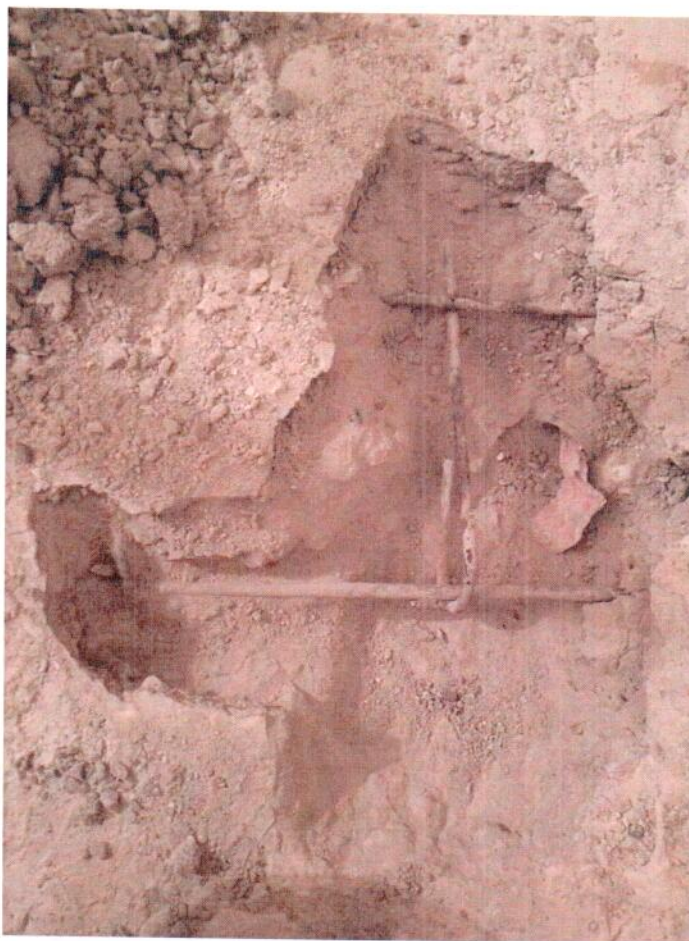
Zbrojenie górne żebra stropu skrzynkowego.
